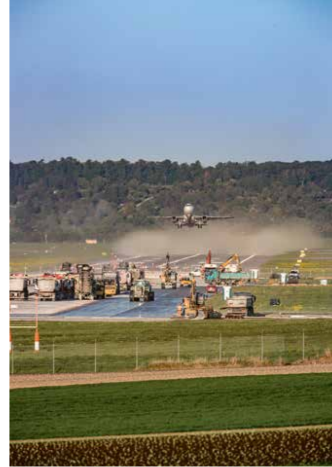
Während des ersten Corona-Shutdowns wurde am STR die Runway teilweise erneuert.
