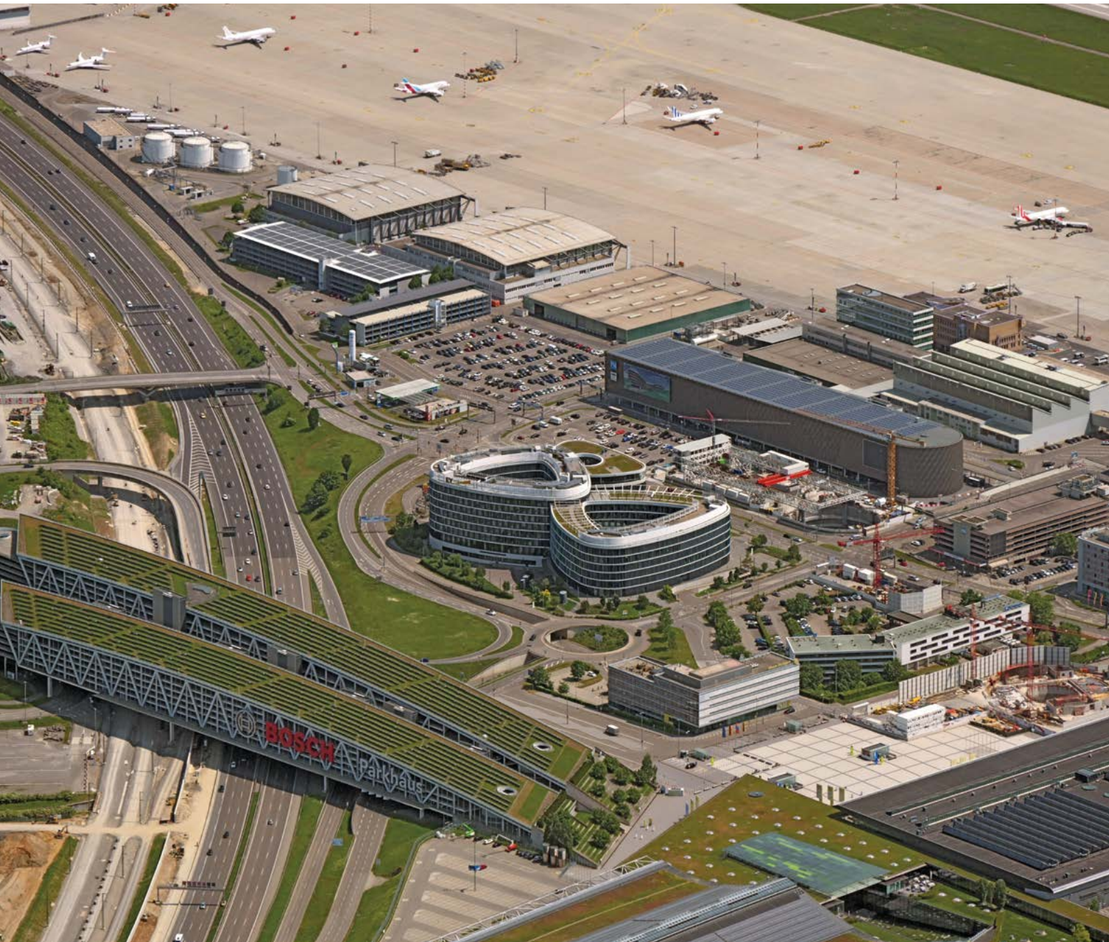
Am STR treffen bald noch mehr Hauptverkehrsachsen der Region Stuttgart aufeinander. Aus der Luft lassen sich die Fortschritte am Bau des Flughafenbahnhofs und der Gleise der Schnellstrecke Stuttgart-Ulm entlang der A 8 gut erkennen.
