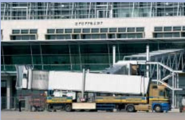
Huckepack zum Montageort: Auf dem Tieflader fährt die Brücke an Terminal 1 vorbei
