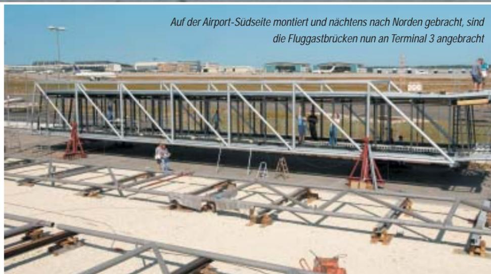
Auf der Airport-Südseite montiert und nächtens nach Norden gebracht, sind die Fluggastbrücken nun an Terminal 3 angebracht
