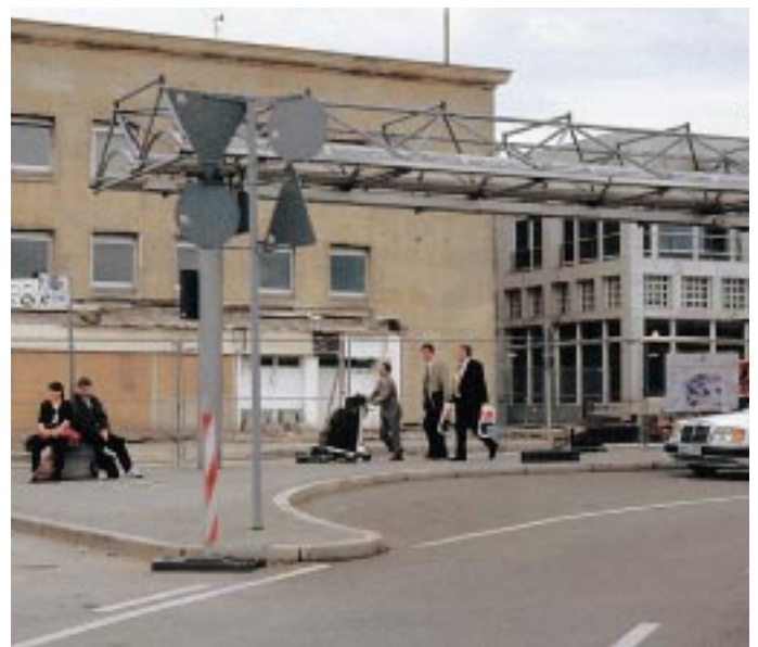
Ein letzter Blick auf das markante Gebäude des Terminal 3 am Stuttgarter Flughafen. Mitte Juli wird es endgültig abgerissen
